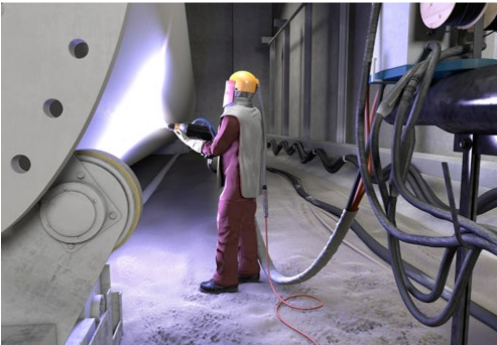
Abb. 127 Beschleunigte Aushärtung von Beschichtungsstoffen
