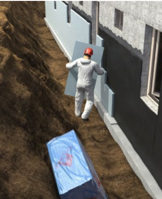
Abb. 91 Abdichtungsarbeiten am Kellergeschoss
