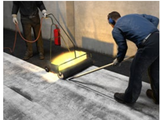
Abb. 90 Aufbringen von Schweißbahnen
