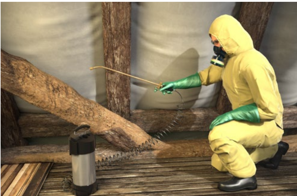
Abb. 88 Auftragen von Holzschutz
