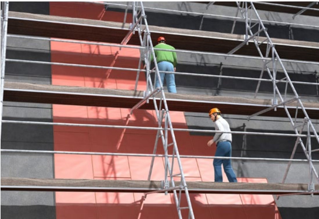
Abb. 123 Arbeitsgerüst an steiler Dachfläche
