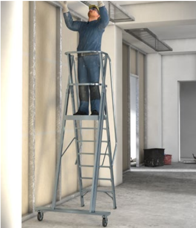
Abb. 49 Arbeiten über Kopf auf einer Podestleiter
