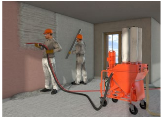
Abb. 69 Putzmaschine
