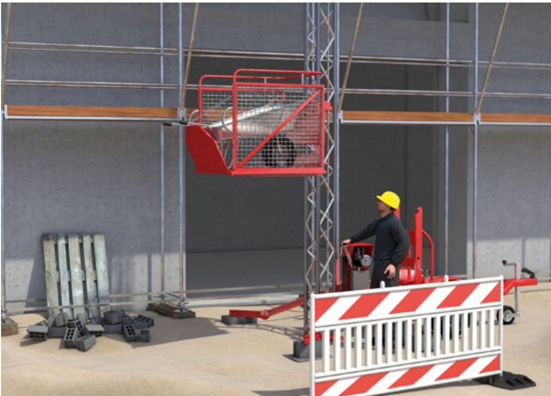
Abb. 72 Lastenaufzug
