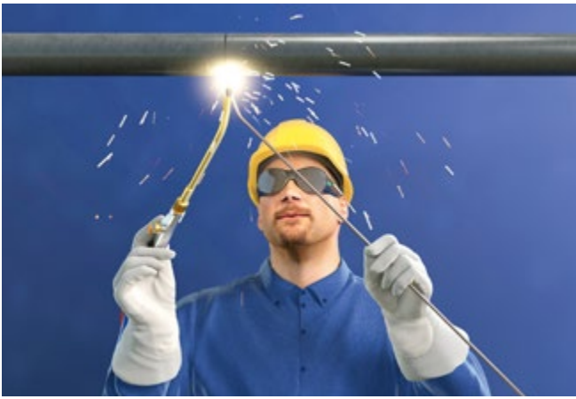
Abb. 26 Funkenflug bei Autogen-Schweißarbeiten
