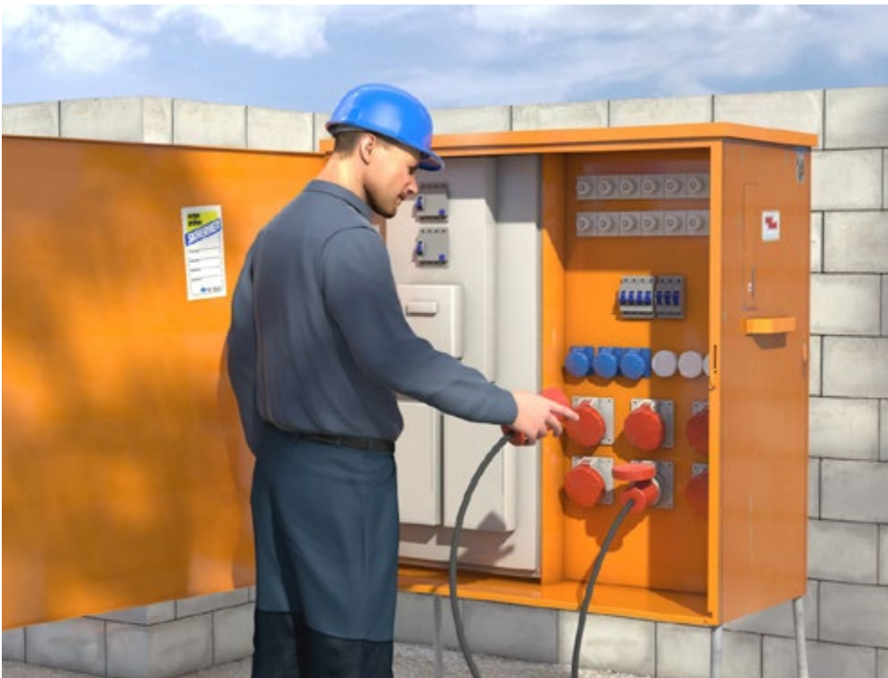
Abb. 14 Verschließbarer Baustromverteiler zur sicheren Stromversorgung einer Baustelle
