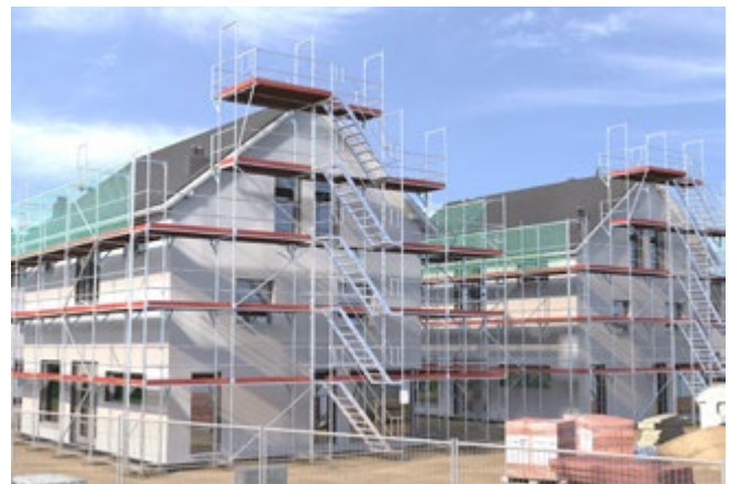
Abb. 60 Fachgerechter Zugang zum Gerüst
