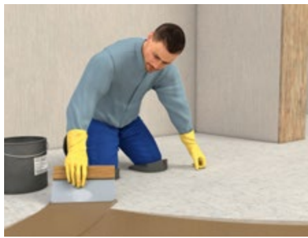
Abb. 94 Klebstoffauftrag mit Zahnspachtel
