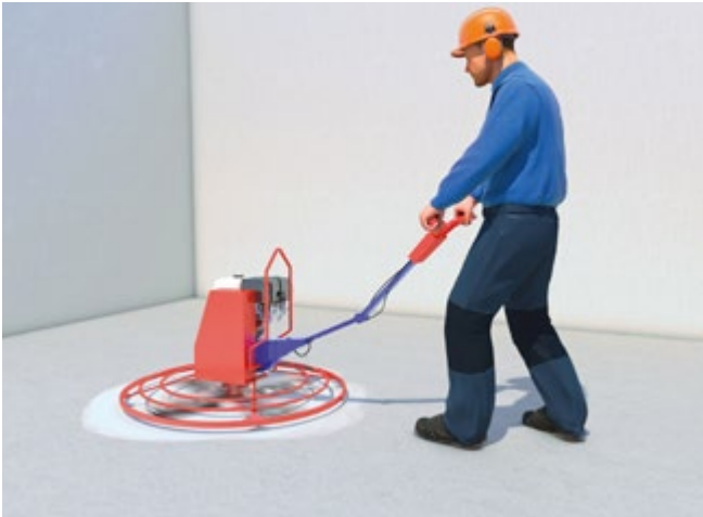
Abb. 68 Glättmaschine
