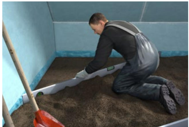
Abb. 106 Estricheinbau
