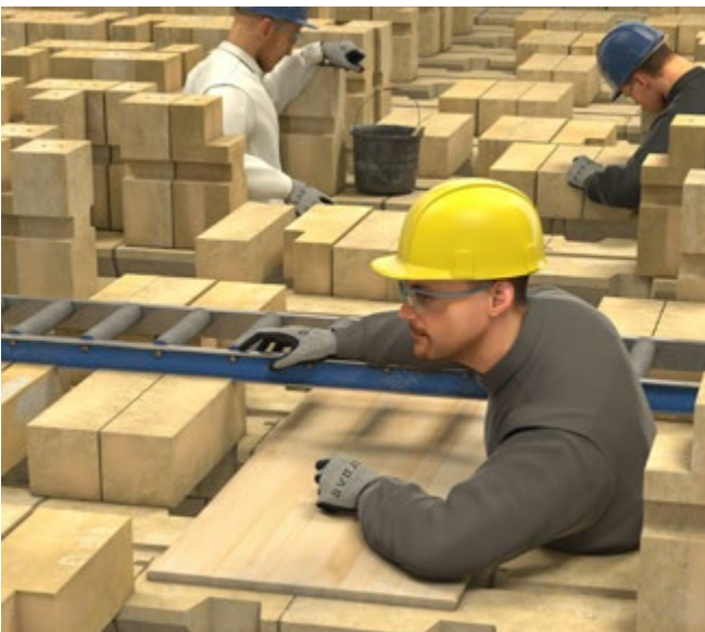
Abb. 135 Zustellung einer Koksofenbatterie
