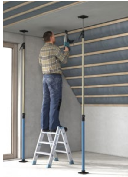
Abb. 149 Montagehilfe für Bauplatten
