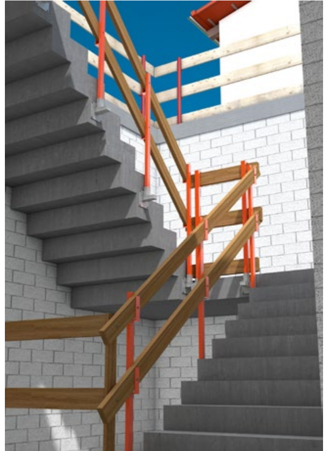
Abb. 132 Treppenaufgang mit Seitenschutz
