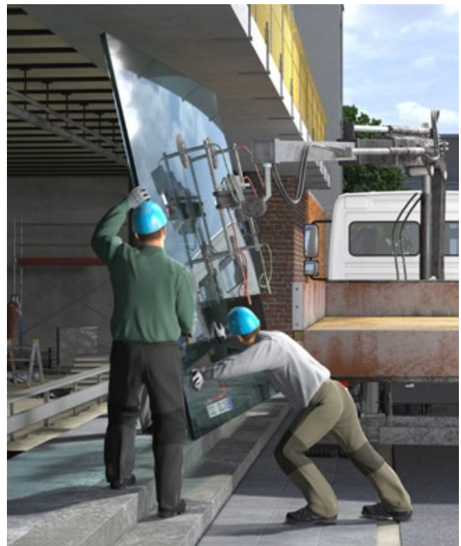
Abb. 112 Transport einer Glasscheibe
