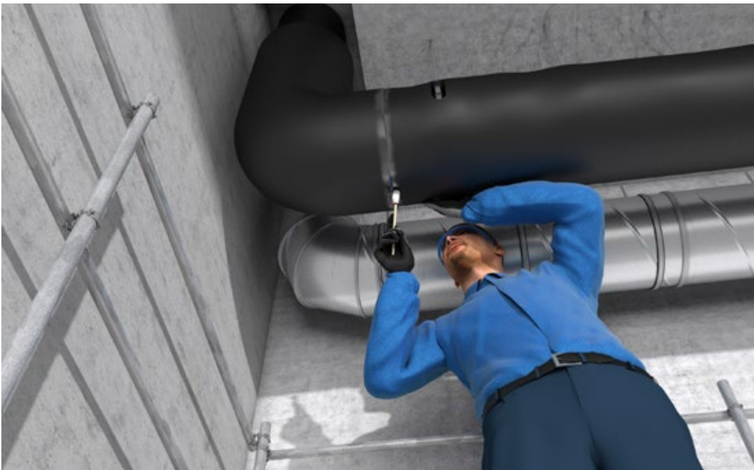
Abb. 150 Kälteschutz- isolierung
