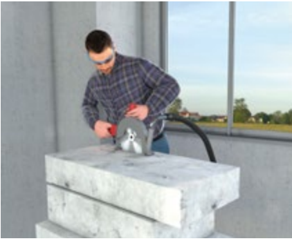
Abb. 157-159 Reduktion der Staubbelastung durch geeignete Absaugung
